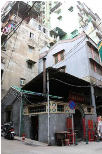
Figura 1.5.1: O Templo Foc Tac Chi do Bairro da Horta da Mitra, e o Clube Comunitário no edifício adjacente.
