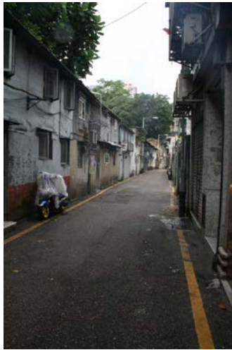
Figura 3.5.7: Estado actual da Rua do Patane.
