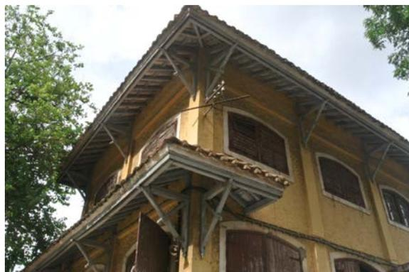
圖 9.5.11：前市政牧場的外露屋簷及飄簷、三角形支架、粗糙的灰泥外牆以及拱形窗戶。
