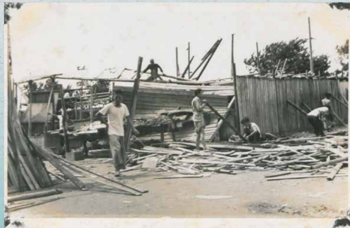
1949/09/08 南灣新填地 — 被吹毀的市政街市 Novo aterro da Praia Grande — o Mercado Municipal destruído pela tempestade Reclaimed land in Praia Grande — municipal market ravaged by typhoon 13.50 cm x 8.74 cm AH2012AV320
