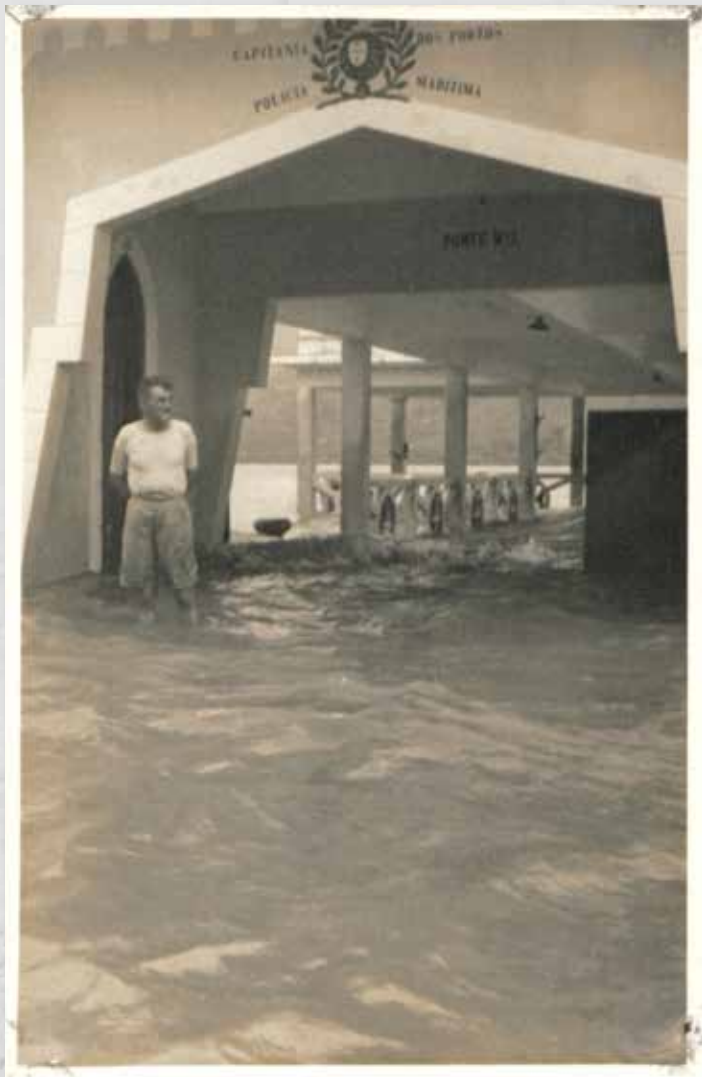
1948/09/03 被浸沒的一號碼頭 Ponte-Cais n.º 1 inundada pela água do mar Pier No. 1 in flood 8.55 cm x 13.07 cm AH2012AV303
