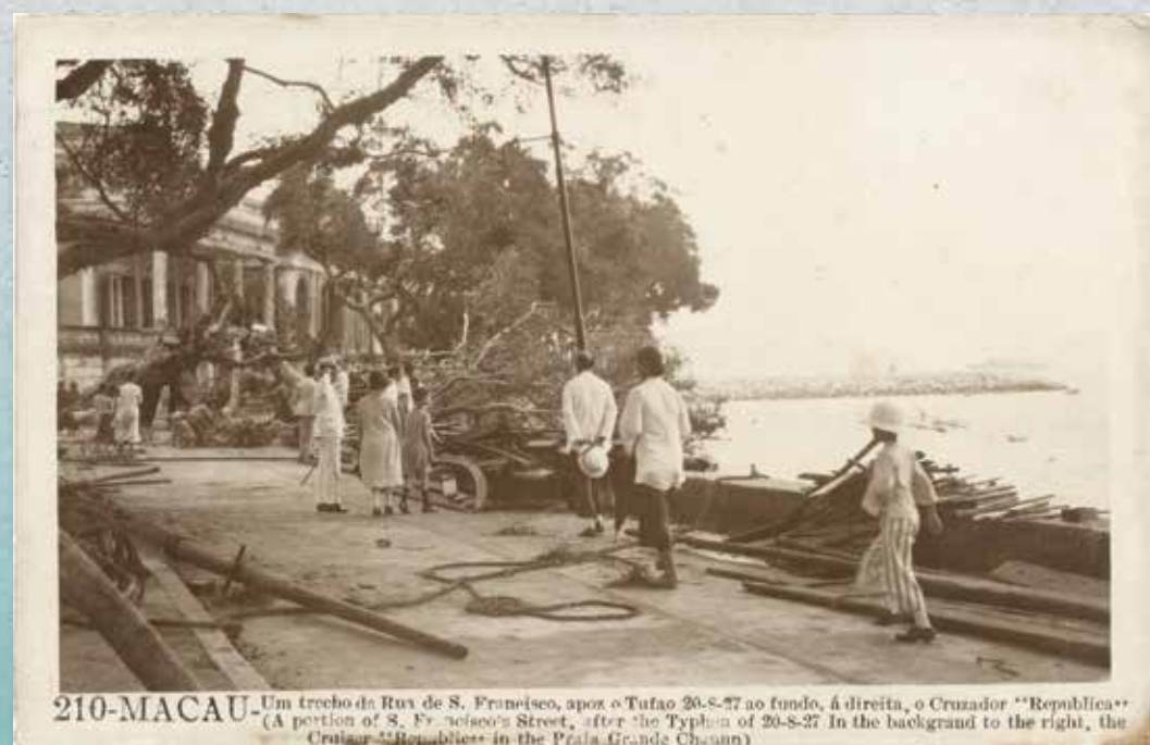
1927/08/20 颱風過後的加思欄馬路 Um trecho da Rua de São Francisco após o tufão A portion of S. Francisco Street after the typhoon 13.83 cm x 8.90 cm MO/AH/ICON/MTL/MO/532
