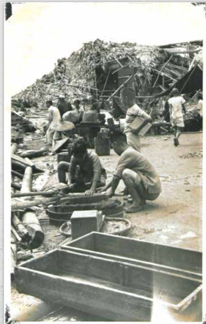
1949/09/08 南灣新填地 — 被吹毀的市政街市 Novo aterro da Praia Grande — o Mercado Municipal destruído pela tempestade Reclaimed land in Praia Grande — municipal market ravaged by typhoon 8.57cm x 13.46 cm AH2012AV323
