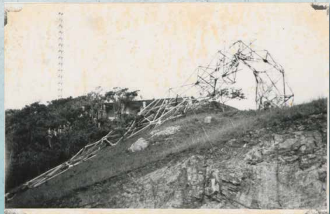
1937/09/02 馬交石炮台被吹塌的電台天線塔 A torre da antena da rádio destruída pelos ventos ciclónicos na Fortaleza de D. Maria II A collapsed radio antenna tower at the Fort of D. Maria II 13.18 cm x 8.59 cm AH2012AV287
