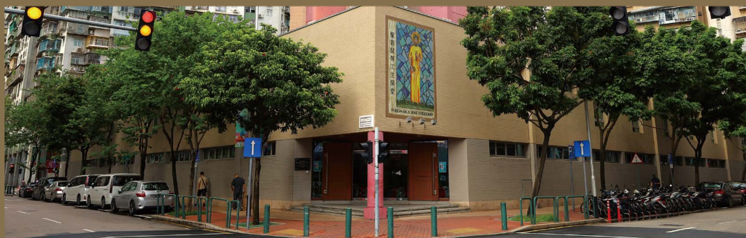
聖若瑟勞工主保堂 St. Joseph the Worker Church 中心街 3 號 看台街 280-300 號 3, Rua Direita do Hipódromo 280-300, Rua da Tribuna
