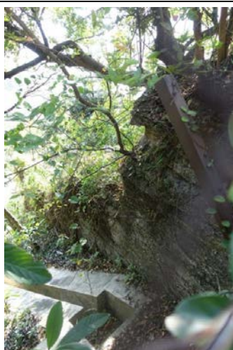
圖 5.5.11：城牆遺跡（近西望洋聖堂一段）東段現況。
