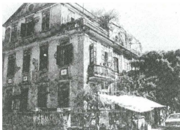
圖 6.5.3：亞利鴉架街 28 號房屋原貌。
