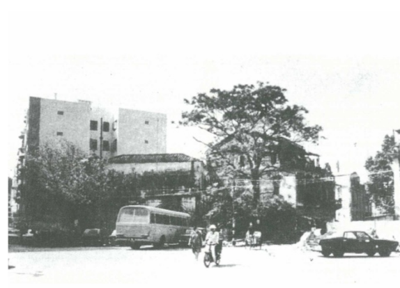
圖 6.5.4：亞利鴉架街 28 號房屋原貌。
