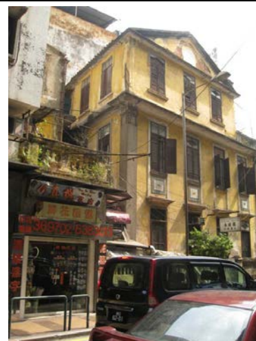
圖 6.5.6：亞利鴉架街 28 號房屋遭局部拆毀前。
