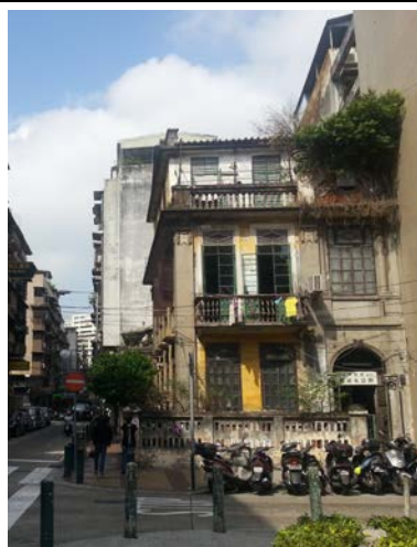
圖 6.5.5：亞利鴉架街 28 號房屋遭局部拆毀前。
