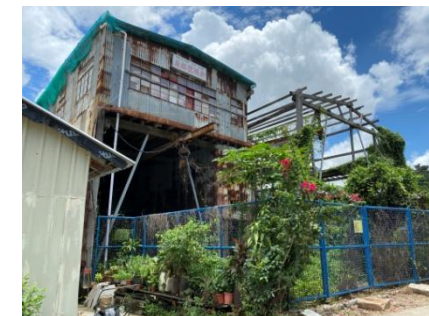
Estado de Conservação actual do estaleiro X-13
