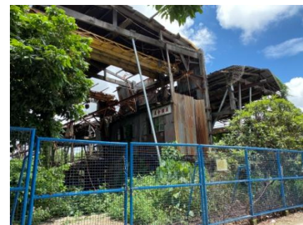
Estado de Conservação actual do estaleiro X-8
