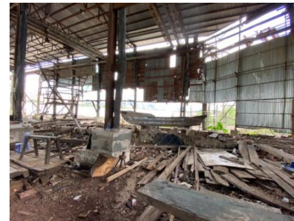
Estado de Conservação actual do estaleiro X-4
