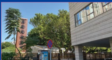
益隆炮竹廠舊址 Antiga Fábrica de Panchões Iec Long
