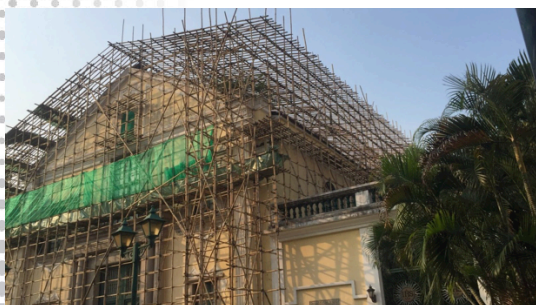
聖奧斯定教堂屋頂修復工程
