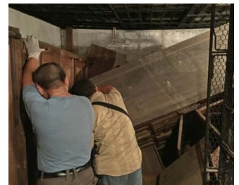
典當業展示館進行維修工程
