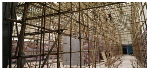
四樓展館維修
