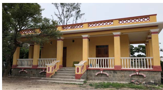
九澳舊癲瘋病院小屋修復工程 (第三期)
