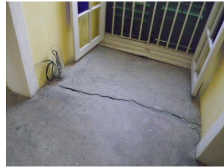
利用測斜儀監測聖奧斯定堂的傾斜情況
